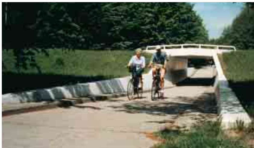
De helling vanuit de tunnel is nog comfortabel te beklimmen
