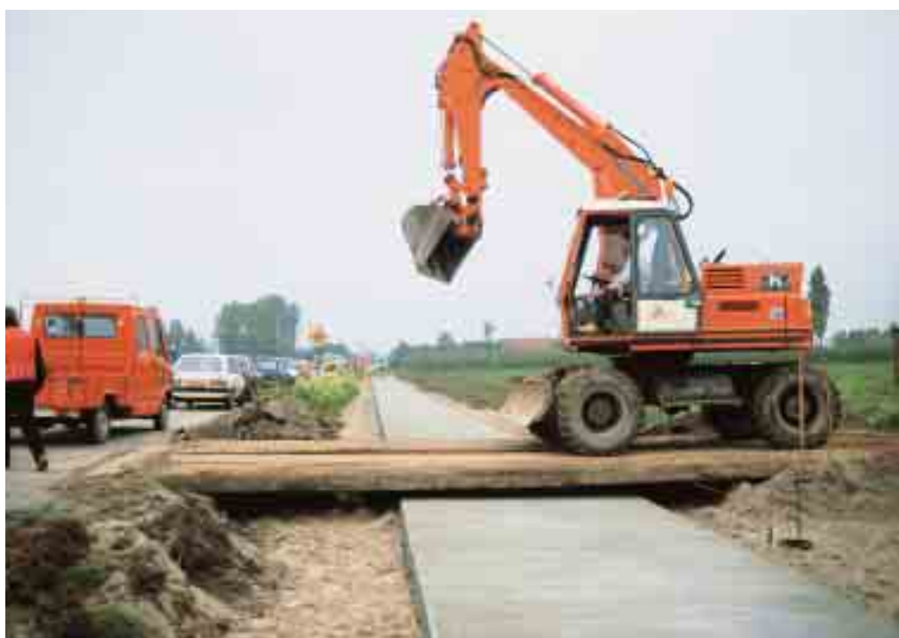
Tijdelijke overbrugging gemaakt met draglineschotten
