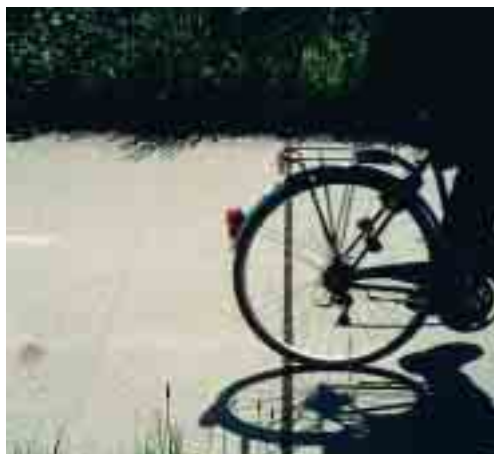
Een uitzetvoeg in een fietspad
