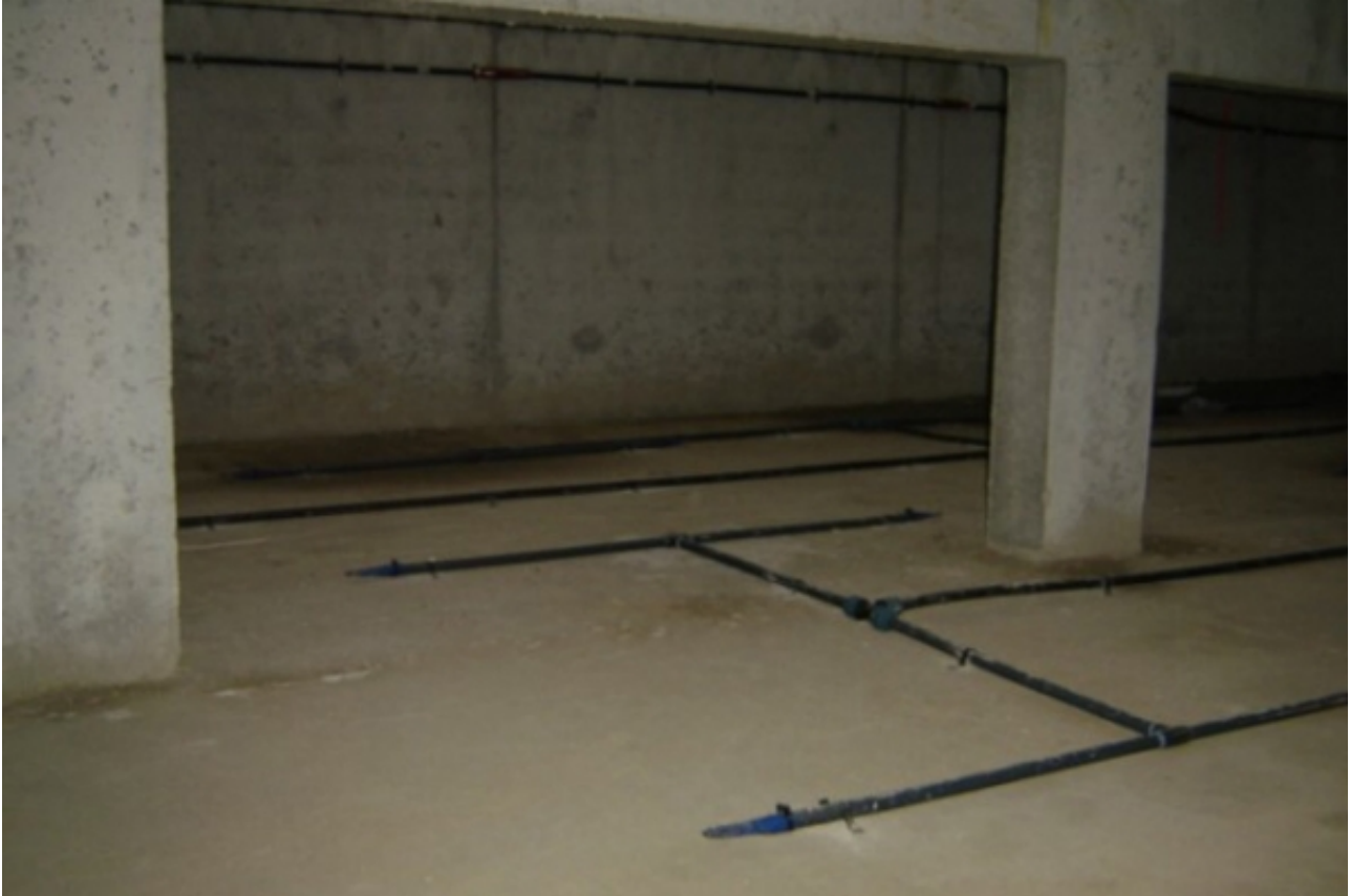
Op de keldervloer met het Aeromix-systeem staan 135 vierkante betonnen kolommen.
